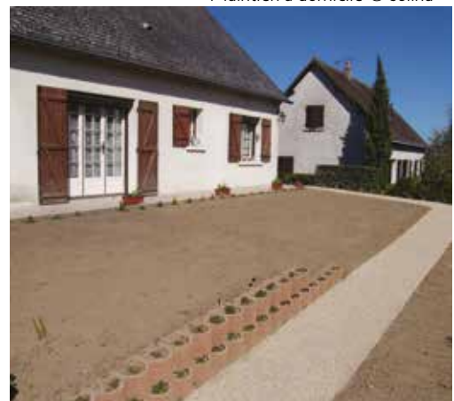
Rampe d'accès - maintien à domicile © soliha
