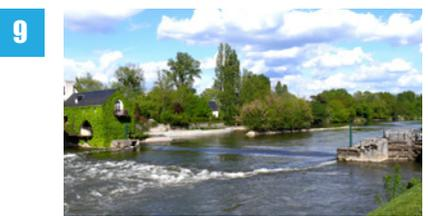
Il s'agit d'un barrage à aiguilles datant de 1841 et classé aux monuments historiques. Il est composé d'une centaine d'aiguilles en bois calées sur une structure mobile métallique. Cas unique sur le Cher, l'écluse est située à gauche du barrage du fait de la position occupée par le moulin.
